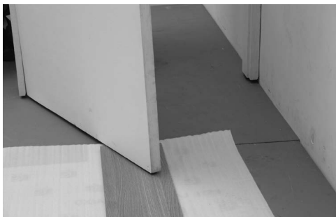
Com manta de polietileno Eucafloor 2 mm
